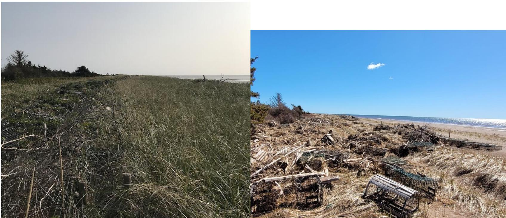
P04 (2023-2024). La photo 2024 a été prise plusieurs mètres derrière celle de 2023 par erreur. On peut tout de même voir le recul et la destruction de la structure de rétention.
